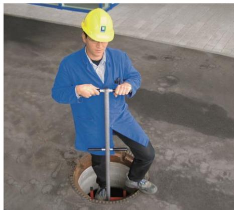
1 Descente dans un puits avec l'aide d'un support
